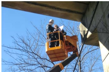
橋梁定期点検調査/ 調査
