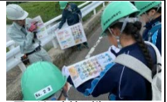
図-14 点検の様子
